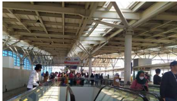
Gambar 3. Lampu Pada Peron Bawah Stasiun Manggarai
